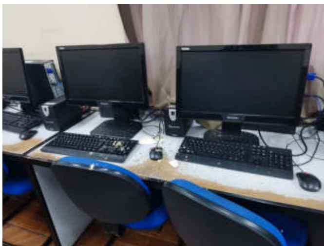
5. Queda de reboco e goteiras em laboratório de Informática
